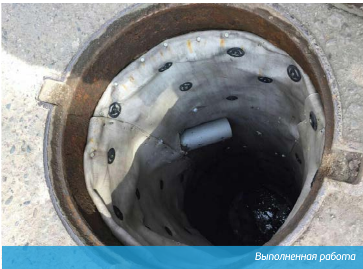
Развертывание и укладка материала
