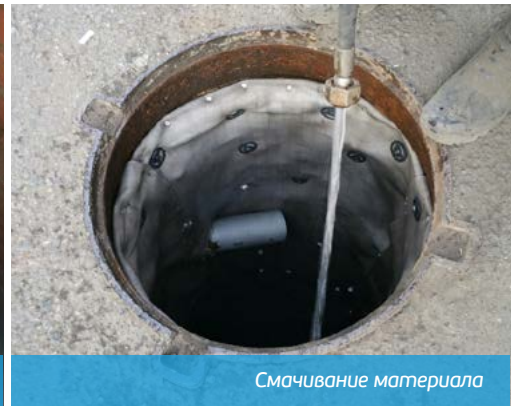
Крепление полотна к стенке колодца
