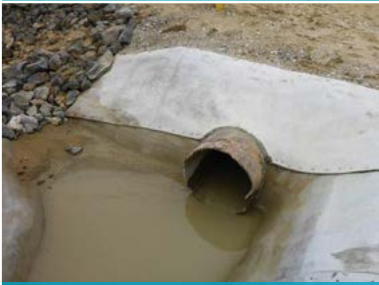
Укладка полотна вокруг трубы
