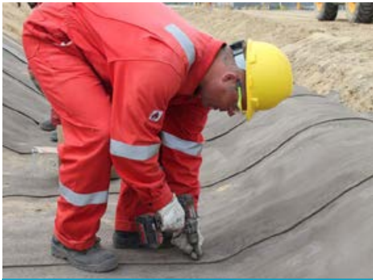
Соединение отрезков винтами
