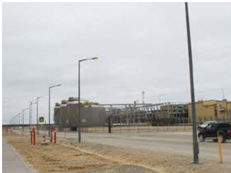
До начала работ
