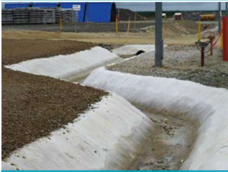
Укладка полотна на изгибах
