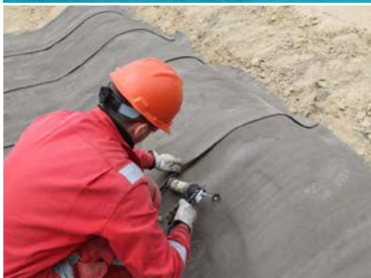
Нанесение герметика на стыки
