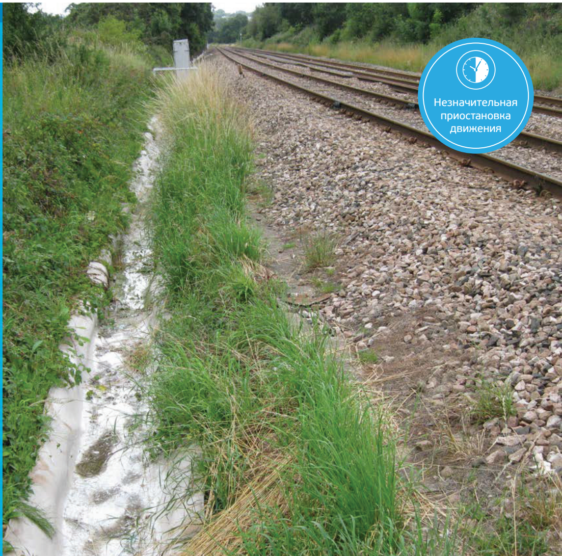
Канавы, укрепленная полотном Concrete Canvas
