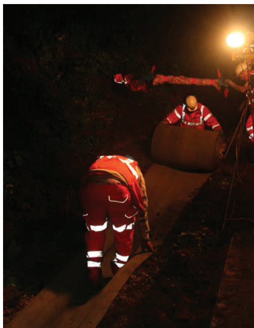
Канавы, укрепленная полотном Concrete Canvas
