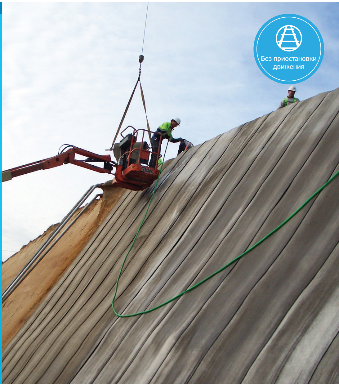
Укладка рулонов бетонного полотна CC8 при помощи пространственной траверсы
