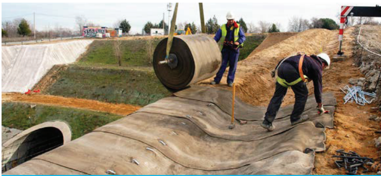
Разворачивание и закрепление полотна
