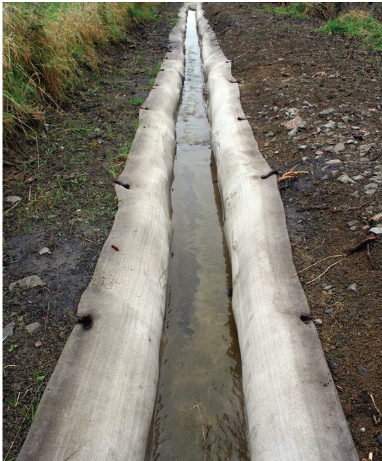
Канал, облицованный бетонным полотном
